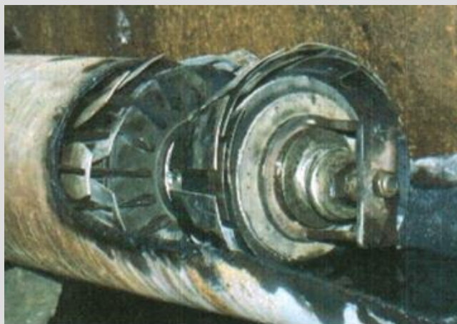
Введение генератора в трубопровод
