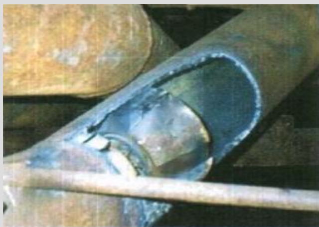
Изготовление контрольного отверстия для удаления генератора
