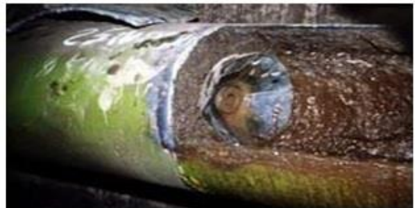
Труба D 500 мм на этапе очистки
