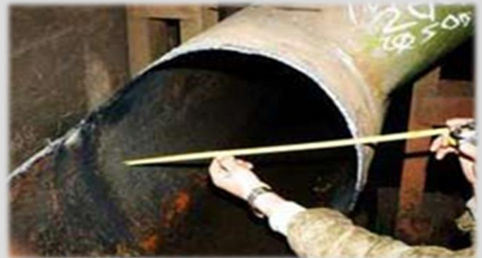
Труба после очистки с использованием кавитационного генератора
