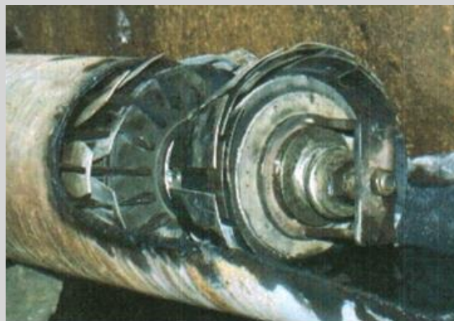
Wprowadzenie generatora do rurociągu
