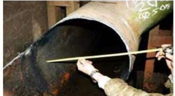
Przykład rury D 500 mm po czyszczeniu
