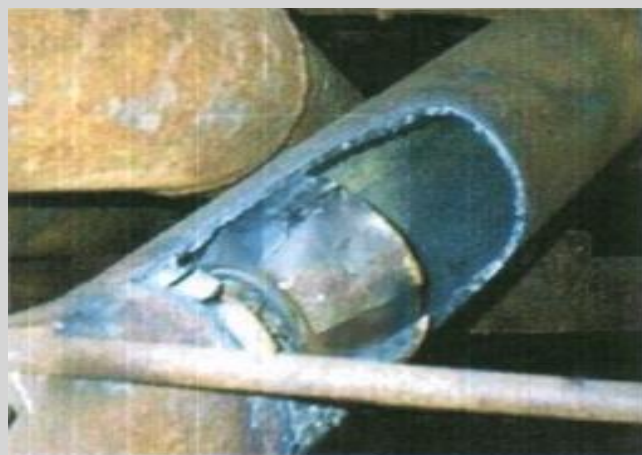
Wykonanie otworu rewizyjnego celem wyjęcia generatora
