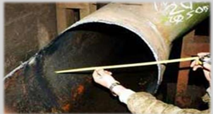
Rura po czyszczeniu za pomocą generatora kawitacyjnego
