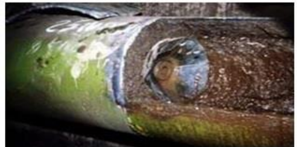
Rura D 500 mm w fazie czyszczenia
