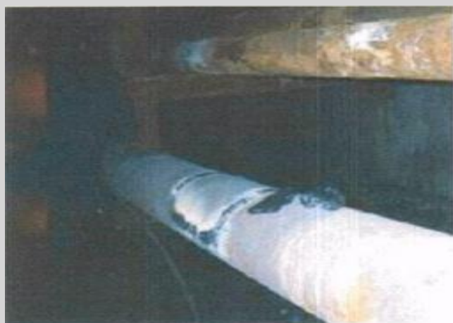
Zaślepienie otworu rewizyjnego oraz włączenie pomp tłocznych
