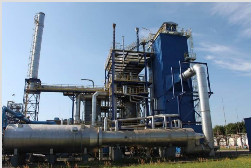
Instalacja czyszczenia kotła odzysknicowego (rurociągi pokryte blachą ocynkowaną) – TASNEE Arabia Saudyjska
